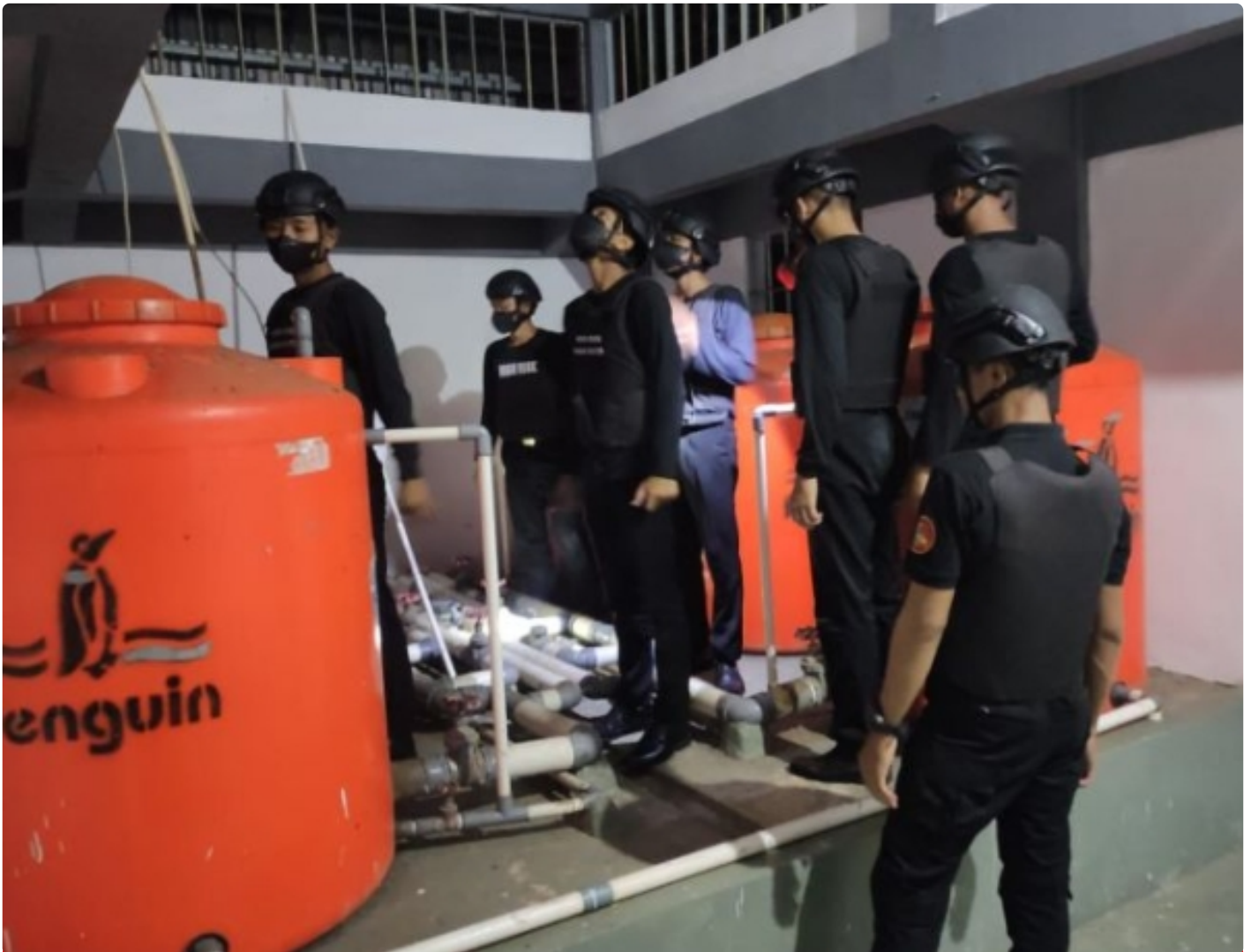
Kontrol Malam Pengairan di Lapas Pasir Putih Nusakambangan
